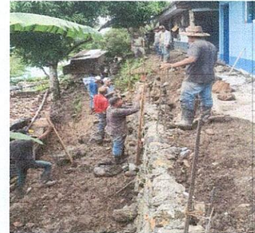
Foto 2: Módulo 10, muro de contención
