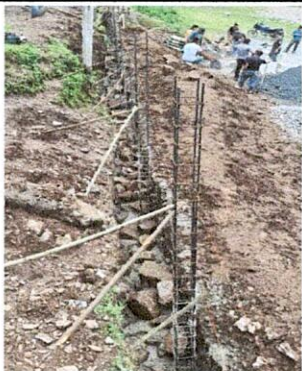
Foto 1: Muro de Contención Frontal
