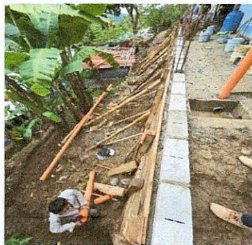
Foto 3: Módulo 10, muro de contención
