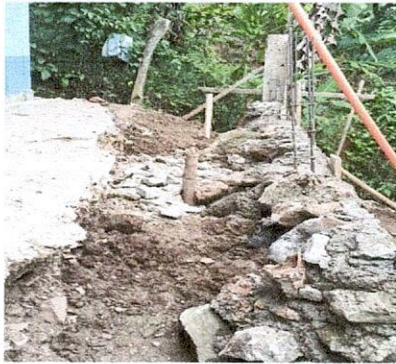
Foto 1: Módulo 10, muro de contención
