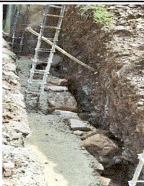
Foto 3: Muro de Contención Frontal
