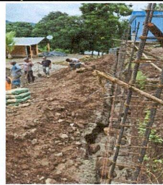
Foto 2: Muro de Contención Frontal
