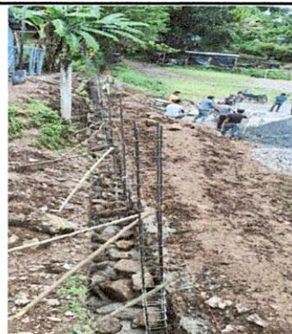
Foto 4: Muro de Contención Frontal
