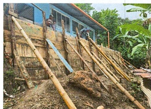
Foto 4: Módulo 10, muro de contención
